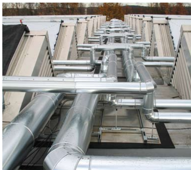
Verrohrung zwischen den Kollektoren vor Inbetriebnahme. Die Kollektoren sind noch abgedeckt. (Abb. Hochschule Offenburg)
